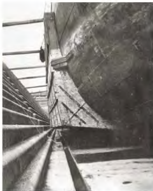
La nave cisterna Sunik nel bacino del porto di Messina nel 1918 per la riparazione con una toppa in legno
