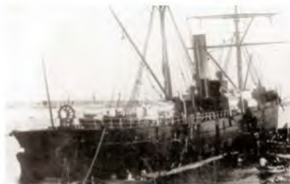
La nave Ville de Messina poi denominata Spes
