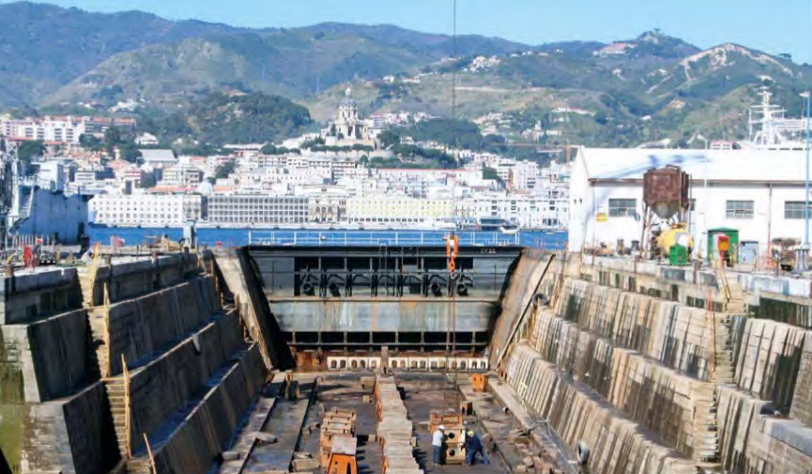
Il bacino di carenaggio in muratura nella zona falcata del porto di Messina
