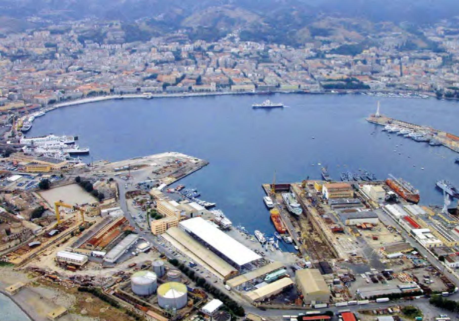
Visione generale dei cantieri Smeb che operarono nella zona falcata del porto peloritano fino ai primi anni del 2000
