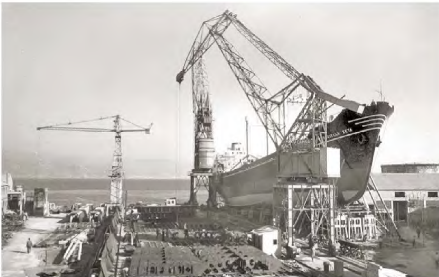
La motonave Graziella Zeta della Società Zeta di Palermo, costruita nel cantiere Cassaro negli anni '60
